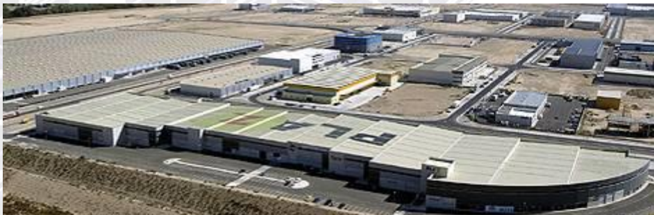
Plataforma Logística de Zaragoza (PLAZA)
